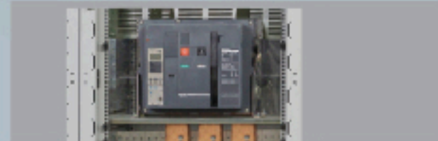
Açık tip şalter formlama detayı
